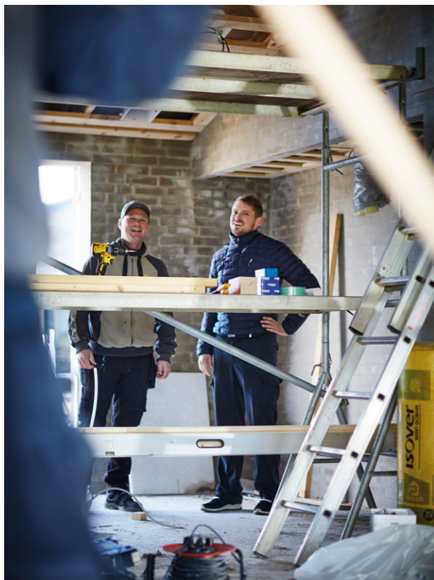
Lars Jørgensen har en kombineret arbejdsuge med henholdsvis kontor-drift og byggeledelse ude på de mange byggepladser
